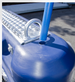
Plasser tauholder i hull på ende av flottør.
