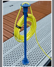
Oppkveilet elkabel festes i opphengstropp, klar til bruk.
